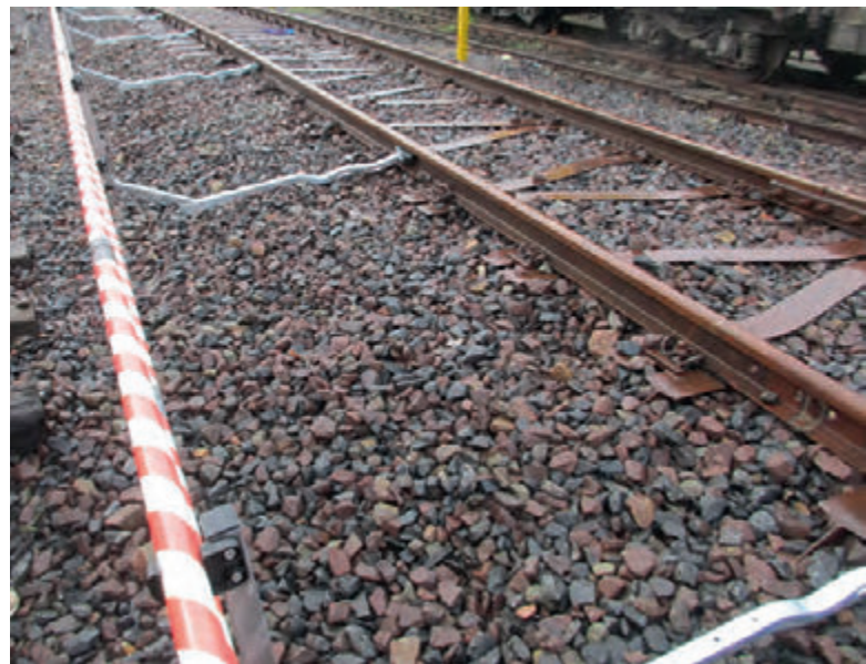
Abb. 3: Feste Absperrung Typ RSS mit Magnetbefestigung
