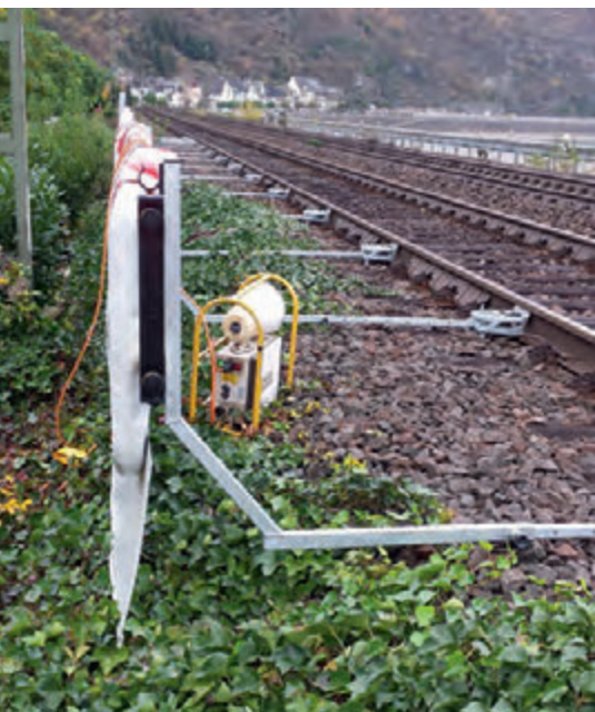
Abb. 6: Feste Abspernung mit Lärmschutzmodul und Autoprowahorn
