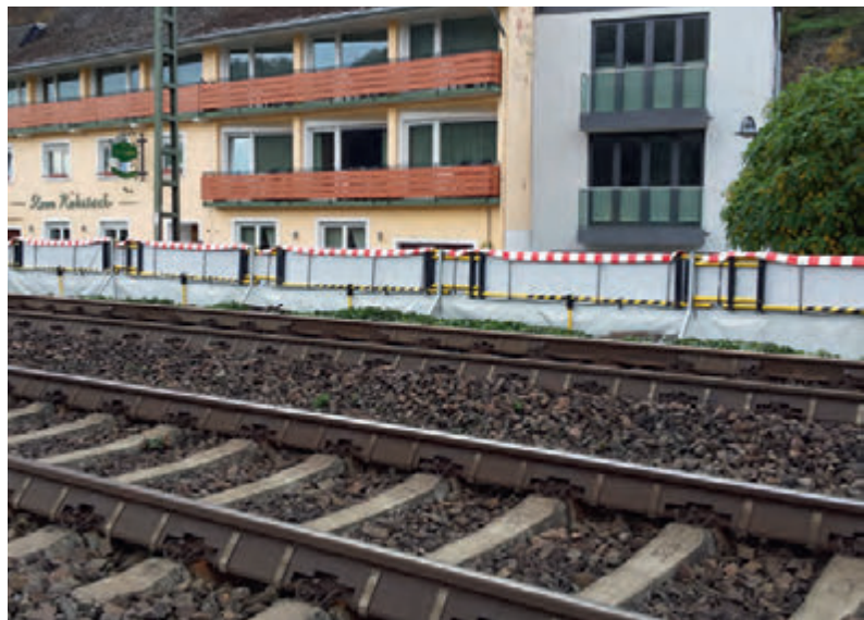
Abb. 5: Feste Abspernung mit Lärmschutzmodulen zum Schutz der Anwohner
