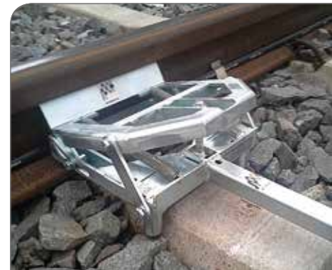
oben: Direkte Montage der Schnellklemme mit nur einer einzigen Befestigungsschraube unten: Maximale Sicherheit bei der DB Netz AG
